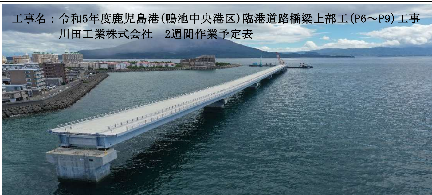
航空写真(P9側から撮影)
