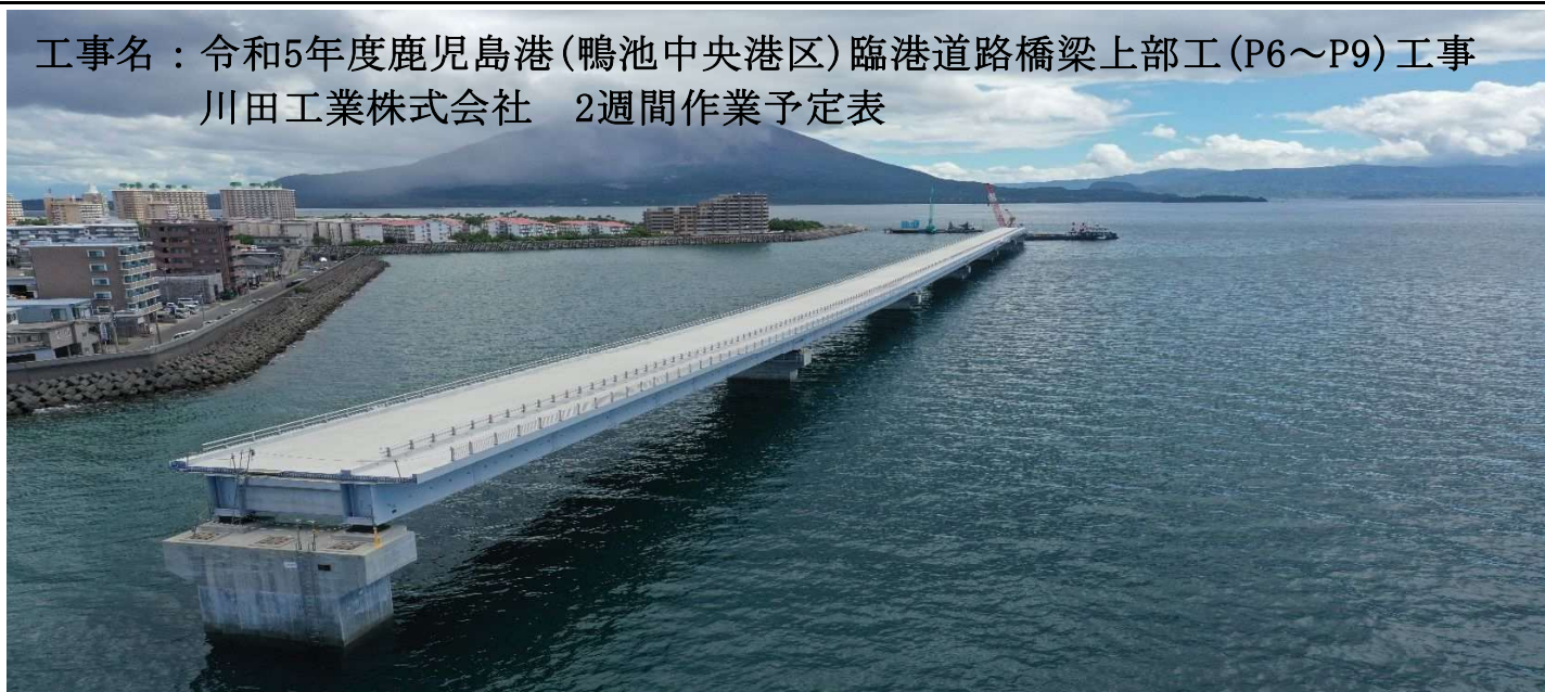
航空写真(P9側から撮影)
