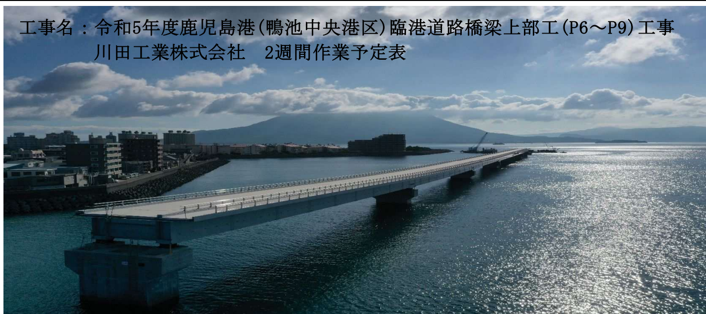
航空写真(P9側から撮影)
