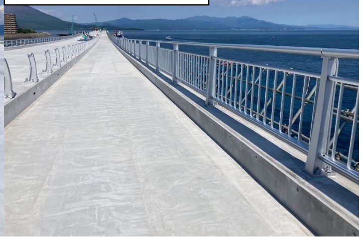
鋼製高欄設置完了(歩道側)
