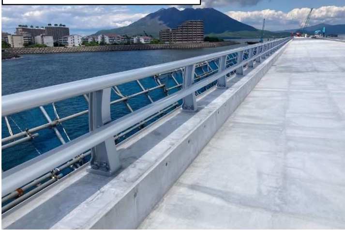
鋼製高欄設置完了(車道側)
