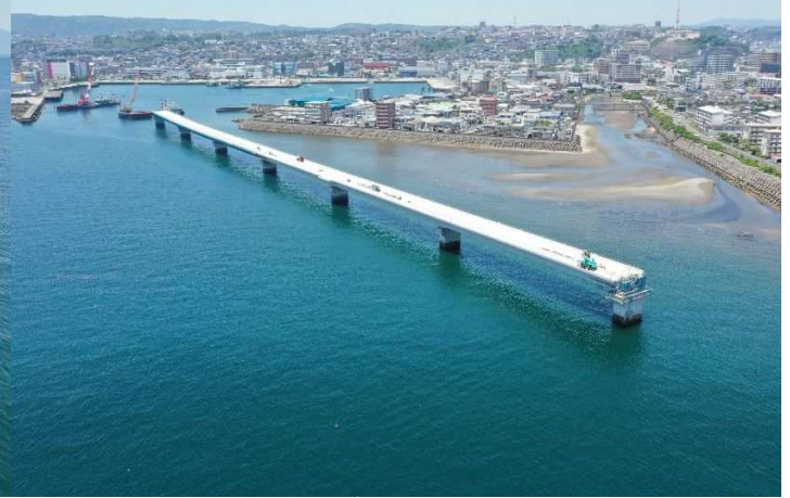
航空写真(P6側から撮影)
