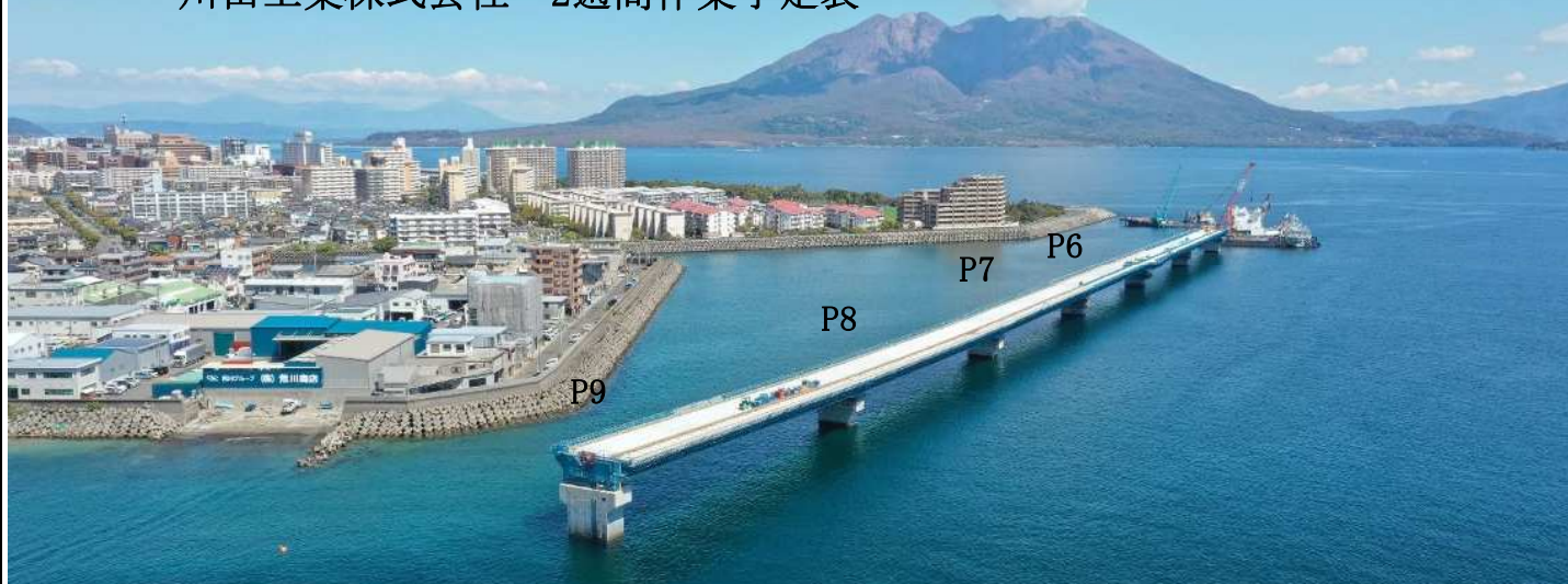
地覆コンクリート打設
