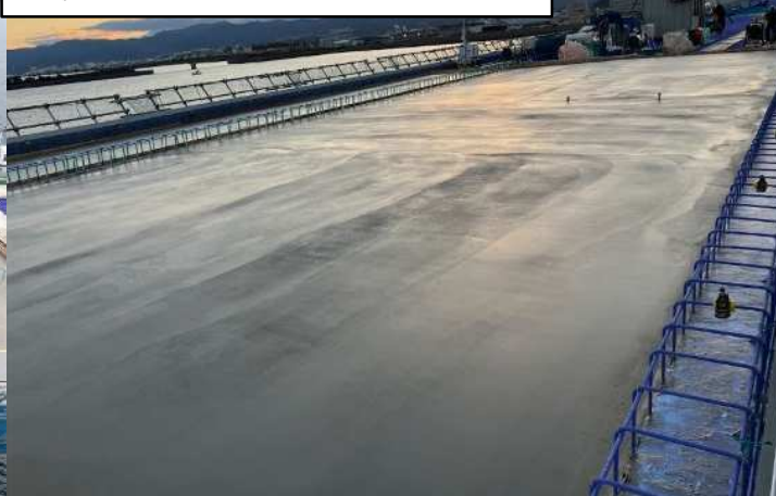
床版コンクリート打設完了(3回目)
