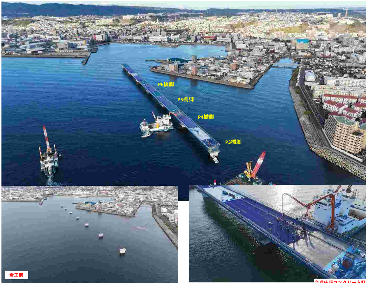
合成床版コンクリート打設
