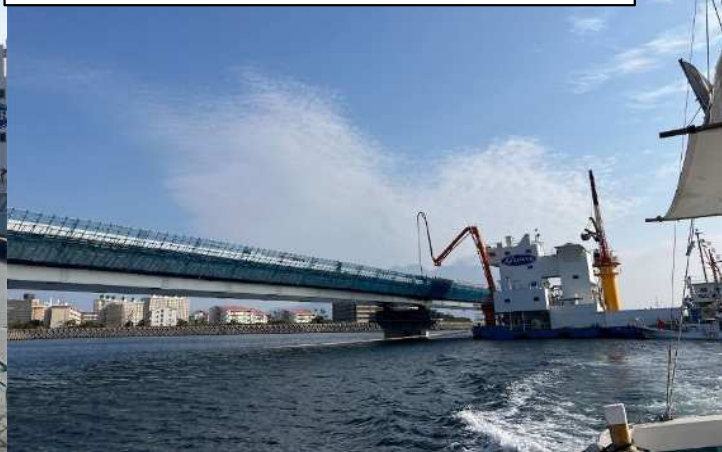
床版コンクリート打設状況(海上から撮影)
