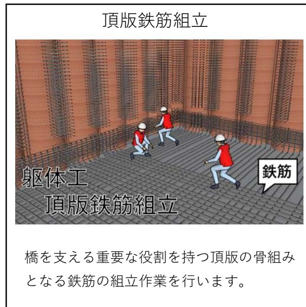
橋を支える重要な役割を持つ頂版の骨組みとなる鉄筋の組立作業を行います。
