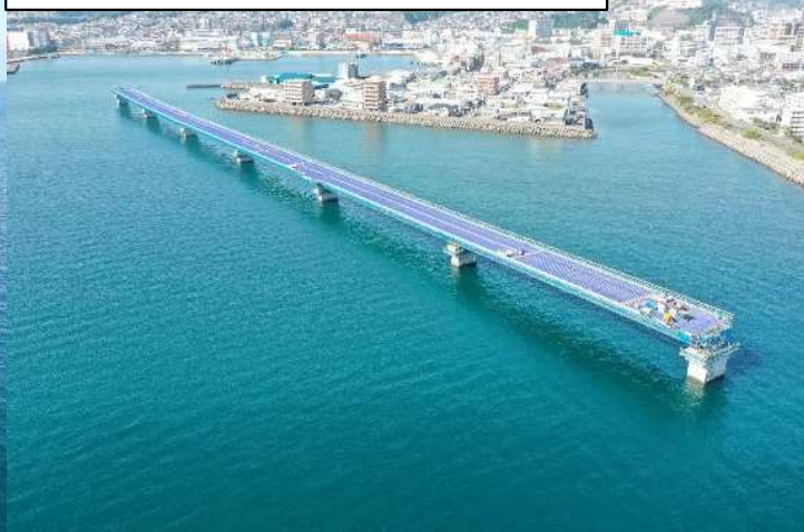
床版鉄筋組立完了（P3側から撮影）
