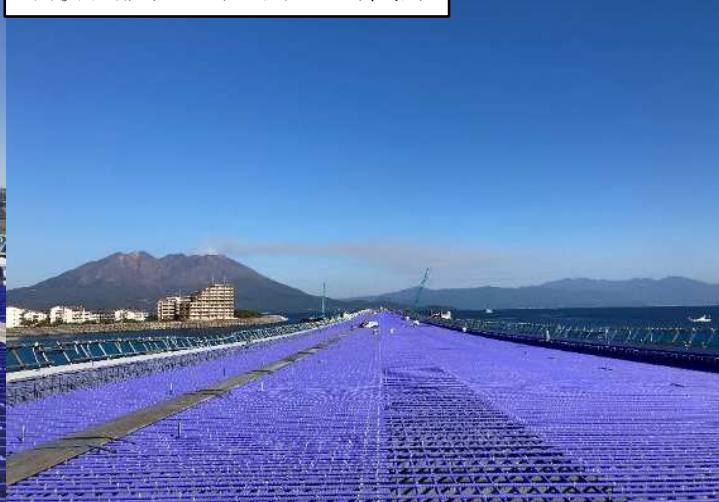
床版鉄筋組立(P9側から撮影)
