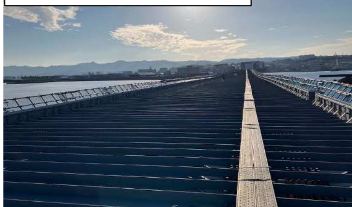
合成床版架設完了(P6側から撮影)
