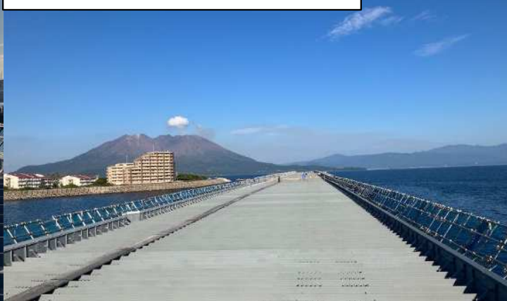
合成床版架設完了(P9側から撮影)
