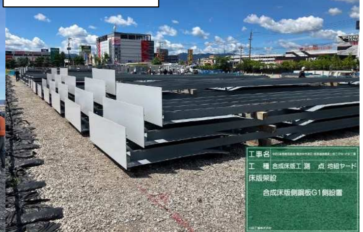
合成床版側鋼板組立
