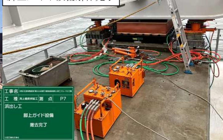
脚上ガイド設備解体完了
