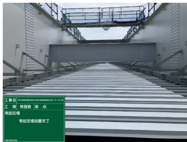
常設足場設置完了(5/15撮影)
