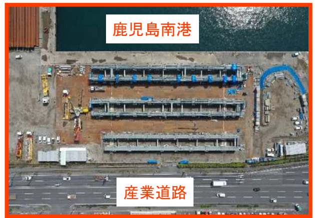
地組ヤード航空写真(3/25撮影)
