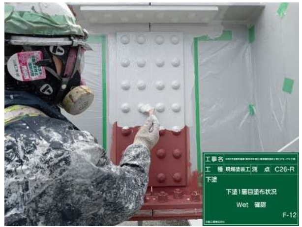
現場塗装状況(3/28撮影)
