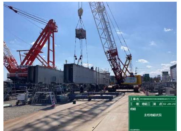
主桁地組状況(2/20撮影)
