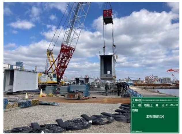
主桁地組状況(2/18撮影)
