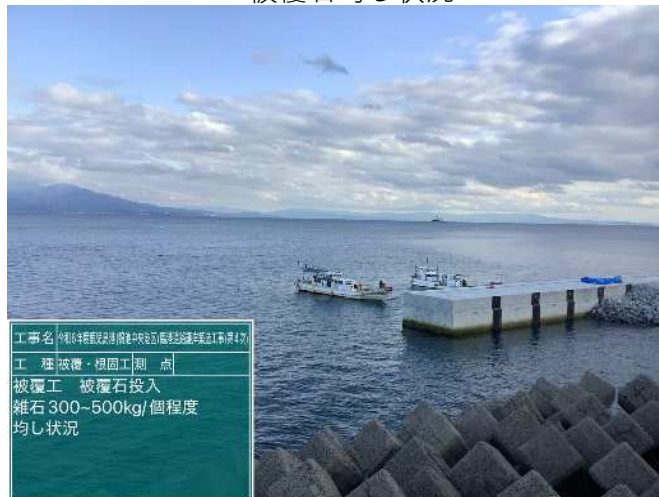
被覆石均し状況
