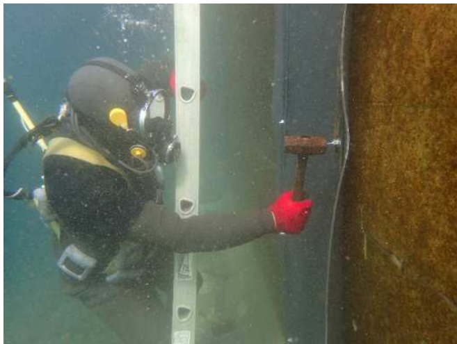
裏込工 防砂目地板取付状況
