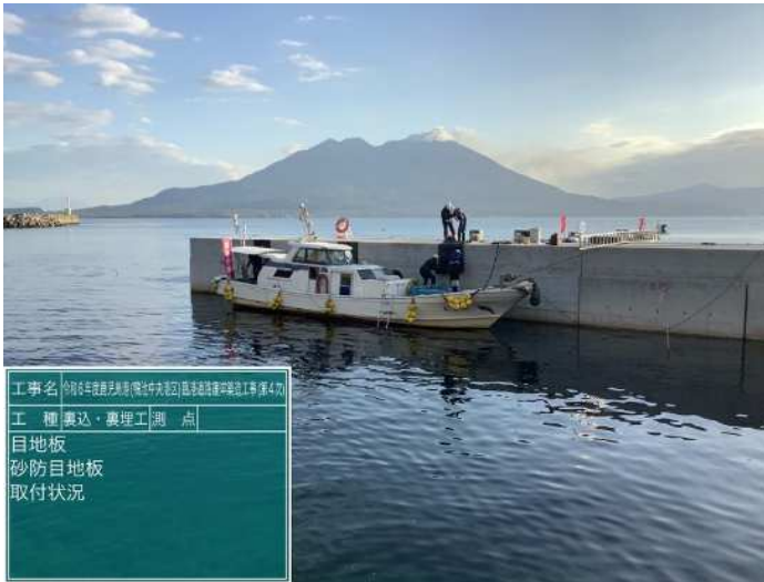
裏込工 防砂目地板取付状況
