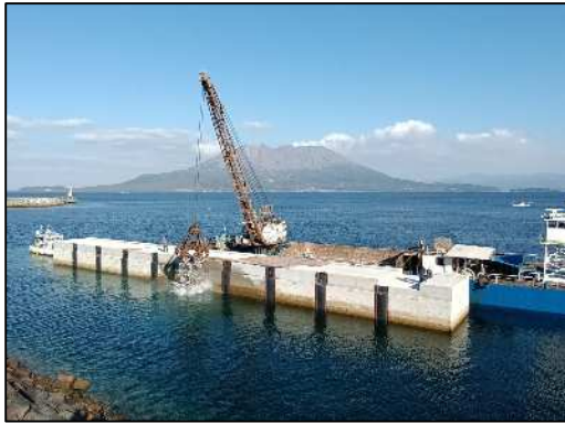
裏込材投入状況
