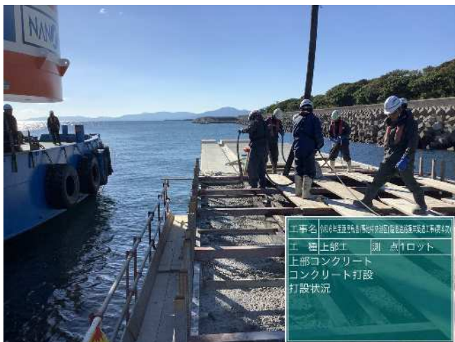
コンクリート打設状況
