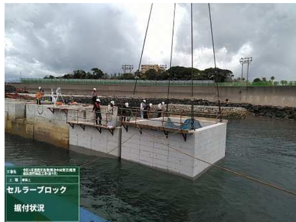
セルラーブロック据付
