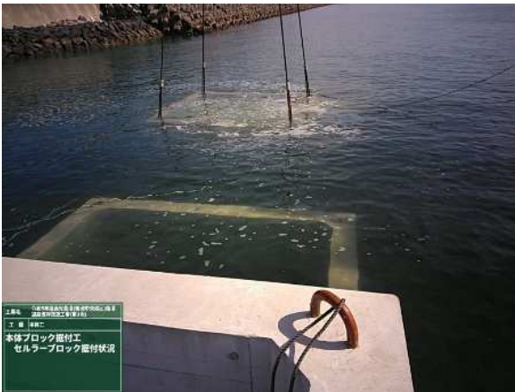
セルラーブロック据付
