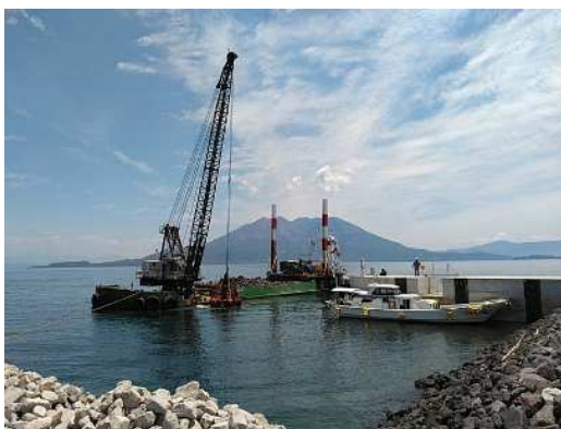
基礎捨石①投入状況
