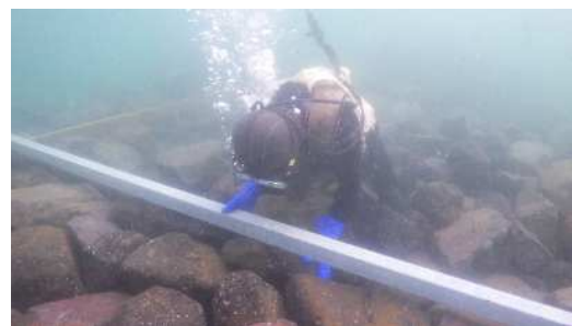
基礎捨石①本均し状況
