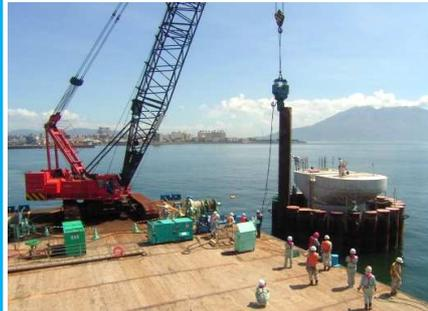
橋脚本体が出来上がったら、海面まで突き出ていた『鋼管矢板井筒』を海底面付近で切断し取り除きます。
