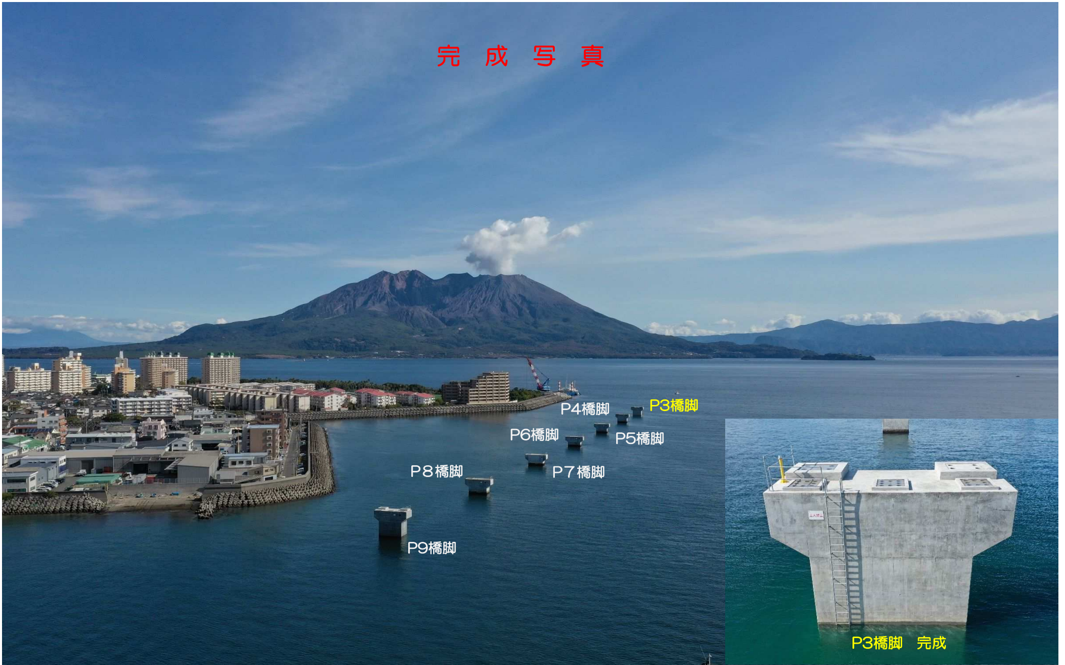
令和4年度鹿児島港(鴨池中央港区)臨港道路橋梁下部工 (P3) 工事
