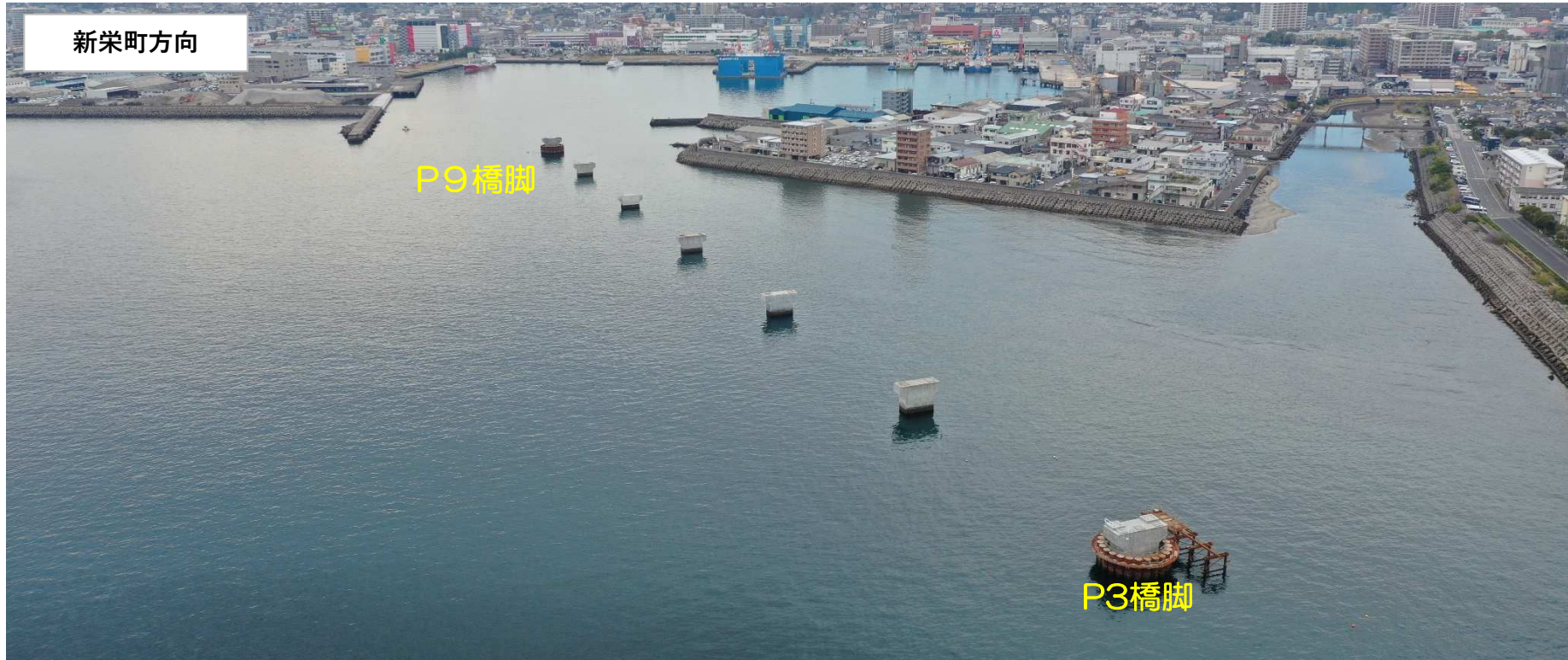
鋼管矢板切断・撤去状況
