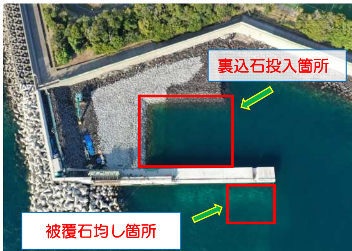
裏込材 雑石5~100kg/個程度 漸次投入状況 石積成地(小笠川砕石)
