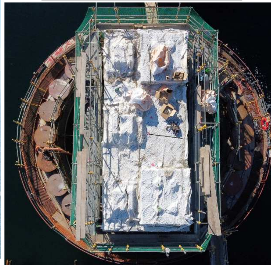
梁コンクリート打設完了
