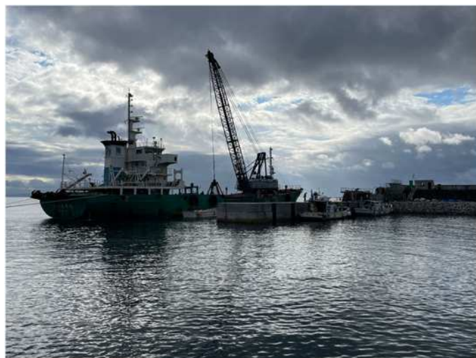
被覆・根固工 被覆石投入
