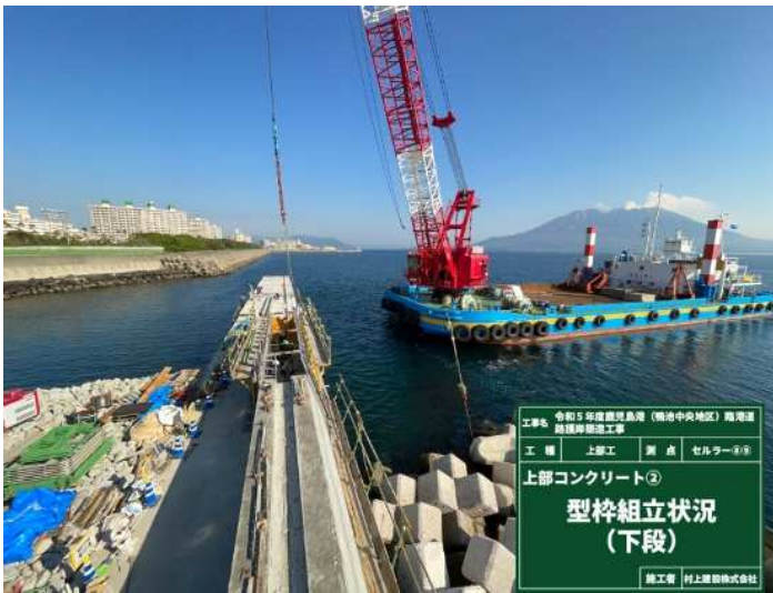
上部工② 型枠組立
