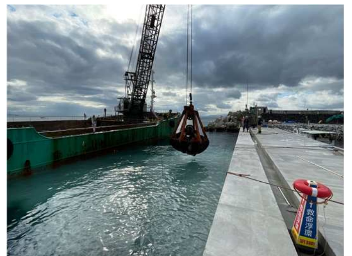
被覆・根固工 被覆石投入
