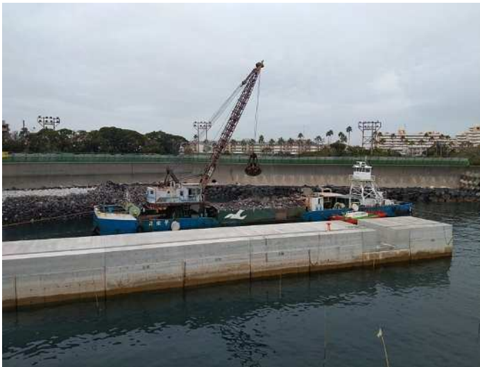
裏込工 裏込石材投入
