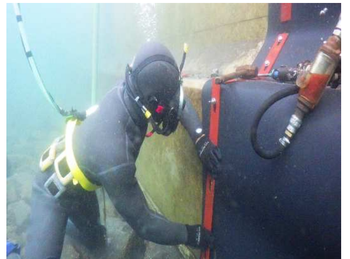
裏込工 防砂目地板取付
