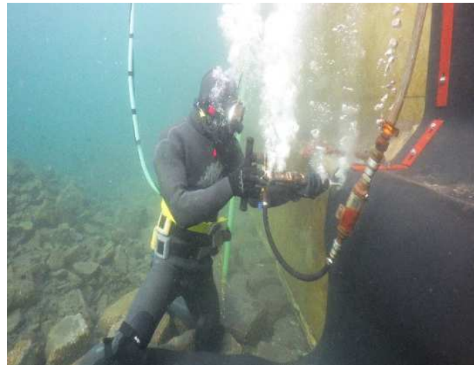
裏込工 防砂目地板取付
