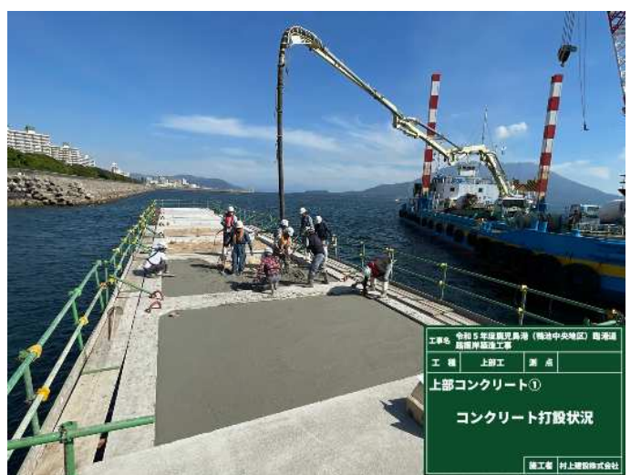
上部工①コンクリート打設
