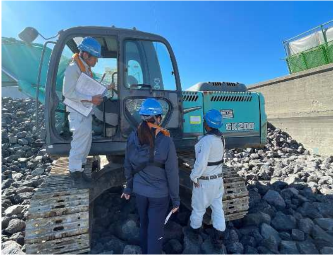
セルラブロック中詰め石材投入
