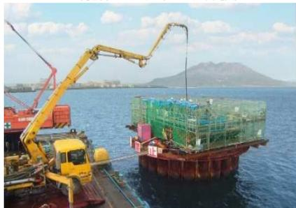
鋼管矢板井筒内に鉄筋コンクリート製の橋脚本体を造ります。足場、鉄筋及びび型枠の設置を行いコンクリートを打設するというサイクルで、下から順番に造り上げていきます。
