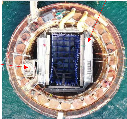
柱鉄筋組立状況 (令和5年9月27日撮影)
