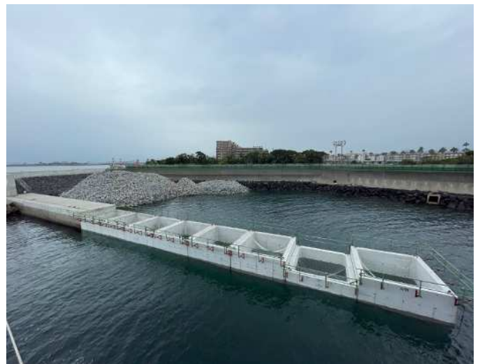
隣接工区据付完了合計8函
