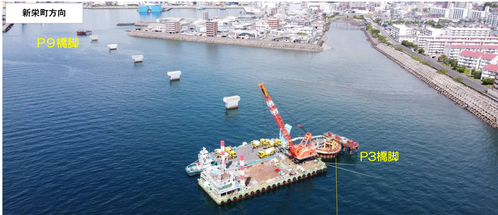
柱コンクリート打設状況 (令和5年9月13日撮影)
