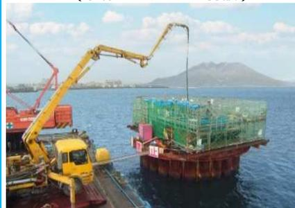
鋼管矢板井筒内に鉄筋コンクリート製の橋脚本体を造ります。足場、鉄筋及び型枠の設置を行いコンクリートを打設するというサイクルで、下から順番に造り上げていきます。
