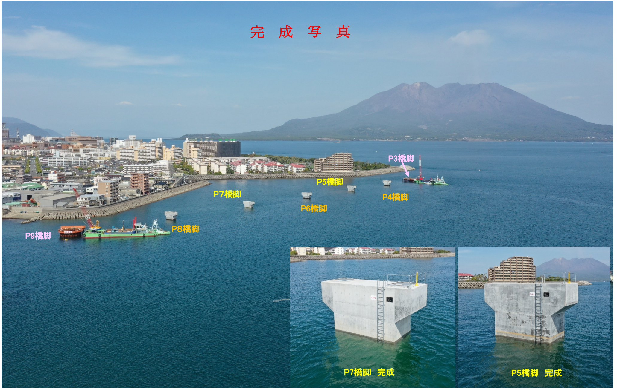
令和3年度鹿児島港(鴨池中央港区)臨港道路橋梁下部工 (P5. P7) 工事
