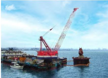
橋脚を造る空間を確保するため、『鋼管矢板井筒』の中の海底を掘り下げます。掘り出された土砂は所定場所に適切に処理します。
