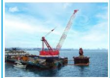
橋脚を造る空間を確保するため、『鋼管 矢板井筒』の中の海底を掘り下げます。 掘り出された土砂は所定場所に適切に処 理します。
