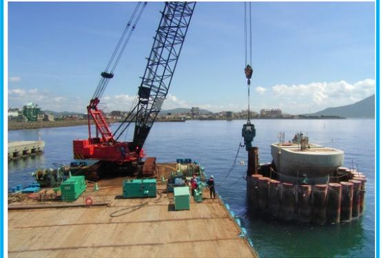
橋脚本体が出来上がったら、海面上まで突き出ている『鋼管矢板井筒』を海底面付近で切断し取り除きます。
