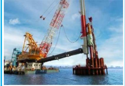
『鋼管矢板』を海底地盤に打ち込みます。鋼管矢板は橋脚1基当たり24本を使用し、円形に打ち込みます。これを『鋼管矢板井筒』と言います。
