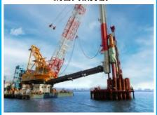
『鋼管矢板』を海底地盤に打ち込みます。鋼管矢板は橋脚1基当たり24本を使用し、円形に打ち込みます。これを『鋼管矢板井筒』と言います。
