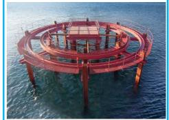
導杭・導枠設置は橋脚を支える基礎となる『鋼管矢板』を海底地盤に鉛直に 打ち込むための定規を設置します。
