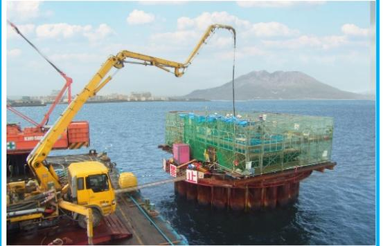
鋼管矢板井筒内に鉄筋コンクリート製の橋脚本体を造ります。足場、鉄筋及び型枠の設置を行いコンクリートを打設するというサイクルで、下から順番に造り上げていきます。
