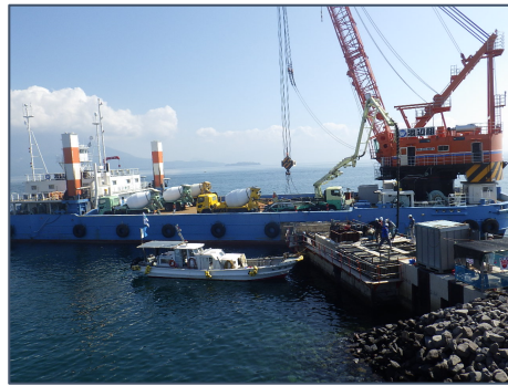
コンクリート打設
