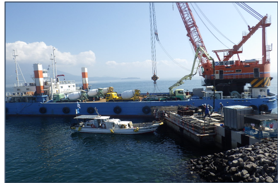
コンクリート打設
