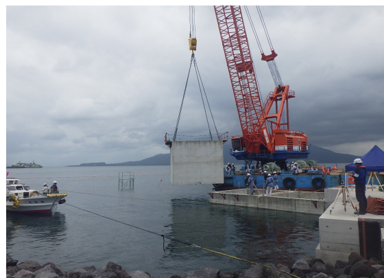
本体ブロック据付
