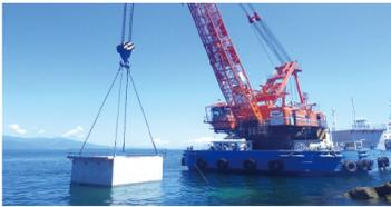
別の場所で製作した護岸の本体ブロックを起重機船で運搬し、潜水士の指示のもと所定の位置に据え付けます。
